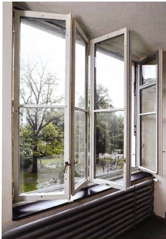
Scuola Dula (1931-33), Lucerna, arch. Albert Zeyer. Sistema dei serramenti scorrevoli a libro e sopra-luce su una delle ante, dopo il restauro del 2008 dello studio di architettura Lengacher Emmenegger. Foto Kantonale Denkmalpflege Luzern, Theres Büttler
