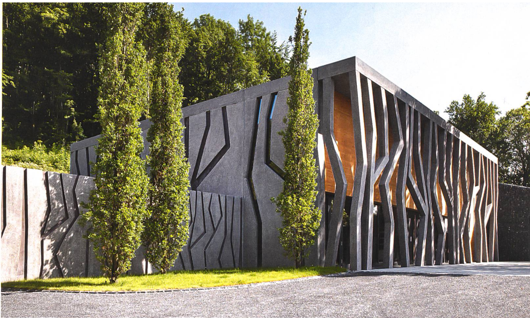
2012 wurde das Gut in Heerbrugg umgebaut und mit einem Neubau erweitert. Foto ZVG
