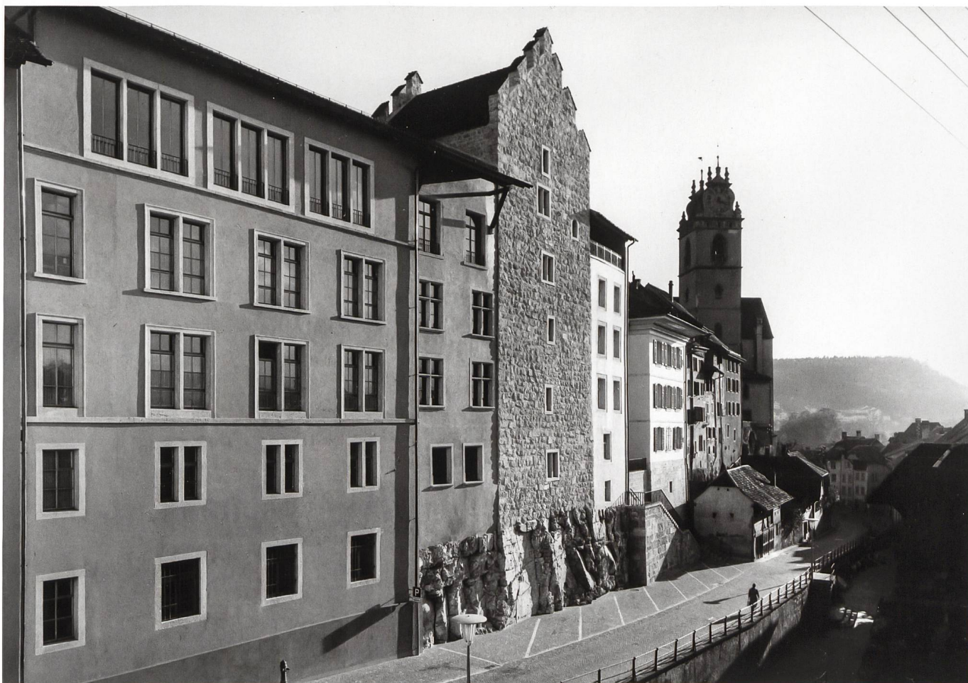
Abb. 11 Aarau, die Rückfassade des Rathauses mit dem Turm Rore nach dem Umbau von 1954–1957. © Kantonale Denkmalpflege Aargau
