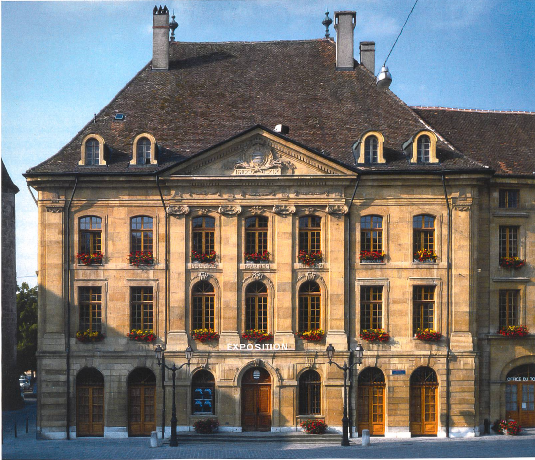
Fig.5 Yverdon, Hôtel de ville. Élégante façade en pierre d'Hauterive conçue en 1768-1769 selon les plans d'Abraham Burnand, avec la collaboration de Bêat de Hennezel. Actuellement en restauration. Photo de Claude Bornand, tirée de Hôtel de Musique und Grande Société in Bern 1759-2009 , Morat 2009, p.115
