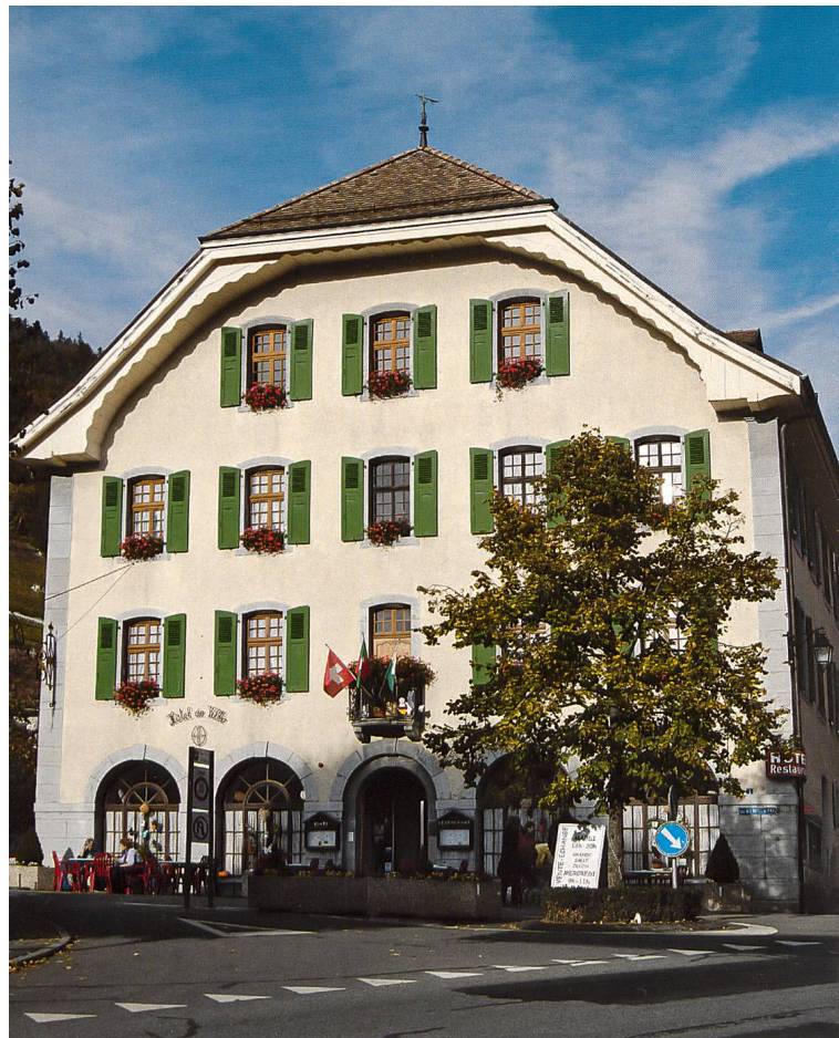
Fig. 12 Ollon, Hôtel de ville construit en 1781-1782. Arcades du rez-de-chaussée semblables à celles de Bex. Restauré et transformé en 1987-1989. Etat 2014. Photo de l'auteur
