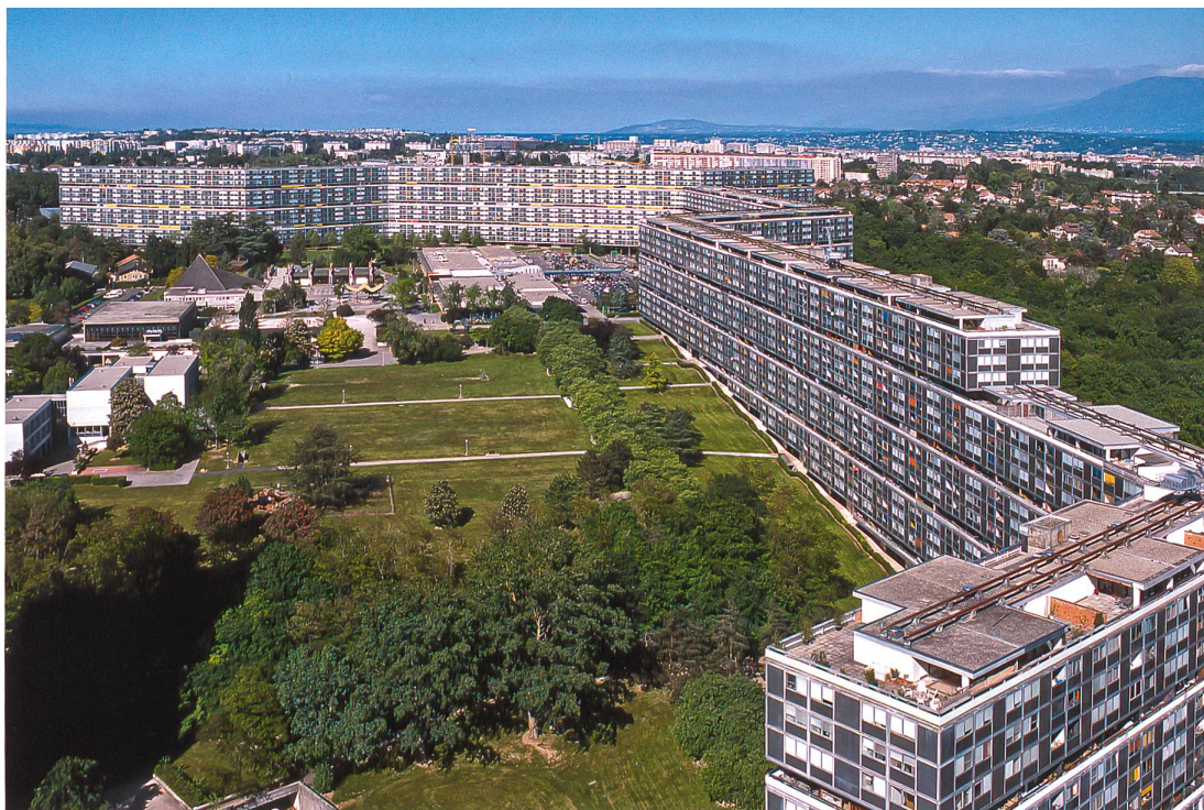
Cité Le Lignon, Vernier bei Genf, 1968–1973, Architekten Addor & Julliard: Beispiel für eine aus denkmalpflegerischer Sicht gelungene energetische Sanierung einer Hochhaussiedlung. Foto Claudio Merlini
