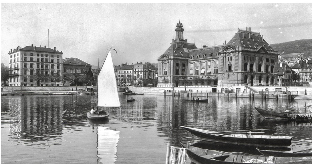
Fig. 10 Neuchâtel, Hôtel Bellevue. A la pointe de la modernité au moment de sa construction en 1860, l'hôtel accueille également quelques locataires permanents, parmi lesquels Philippe Suchard (fils), sa femme et ses enfants qui y résident durant une dizaine d'années. Photo Victor Attinger (Institut suisse pour la conservation de la photographie)
