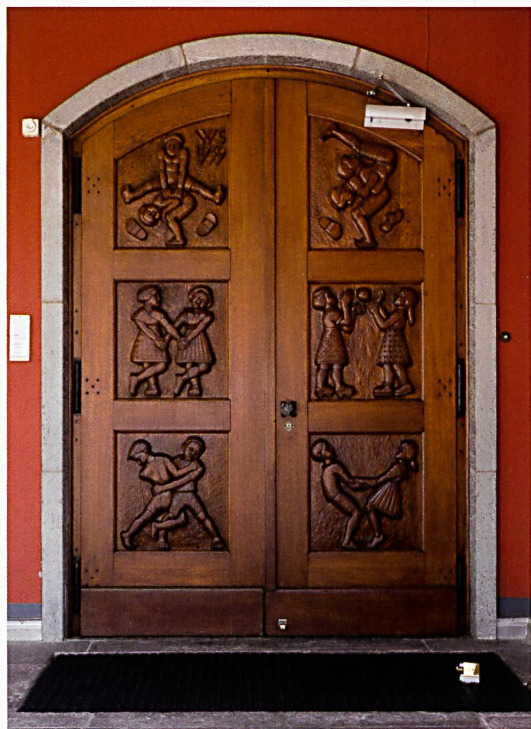
Scuole elementari di Minusio (1937-40) progettate da Bruno Brunoni. Particolare del portone d'ingresso ligneo con rilievi di Wilhelm Schwerzmann. Foto Claudio Berger
