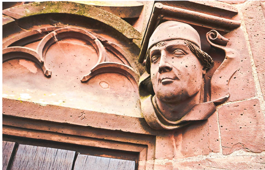
Abb. 11 Selbstportrait des Hans Nussdorf mit seinem Meisterzeichen am Türsturz des ersten Treppentürmchens an der Nordfassade des Martinsturms. Kopfkonsolle und Türsturz bestehen aus einem Werkstein. Foto Dirk Weiss, 2019
