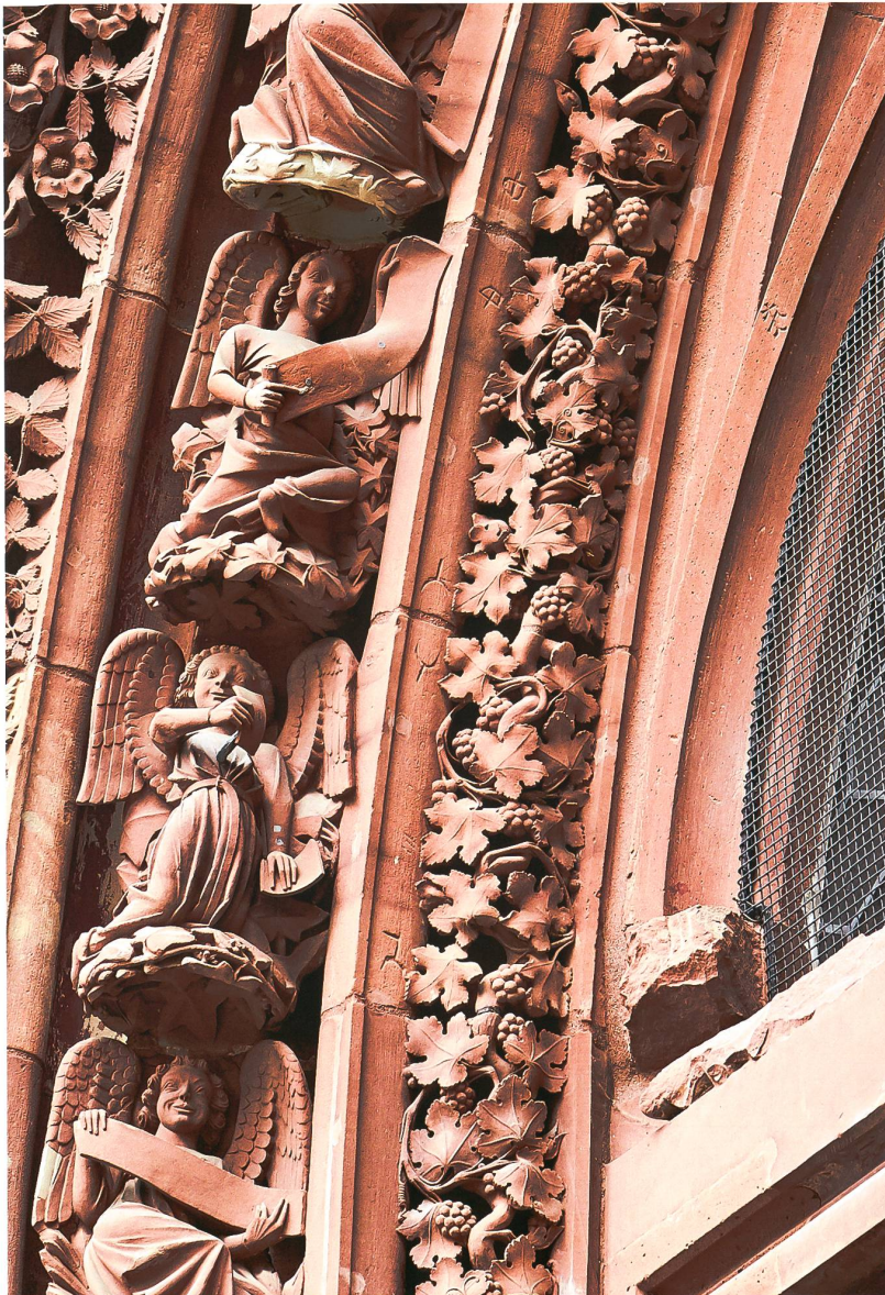
Abb. 7 Detailaufnahme der Archivolten am Hauptportal. In Fugennähe sind paarige Versatzzeichen zu erkennen. Foto Dirk Weiss, 2019
