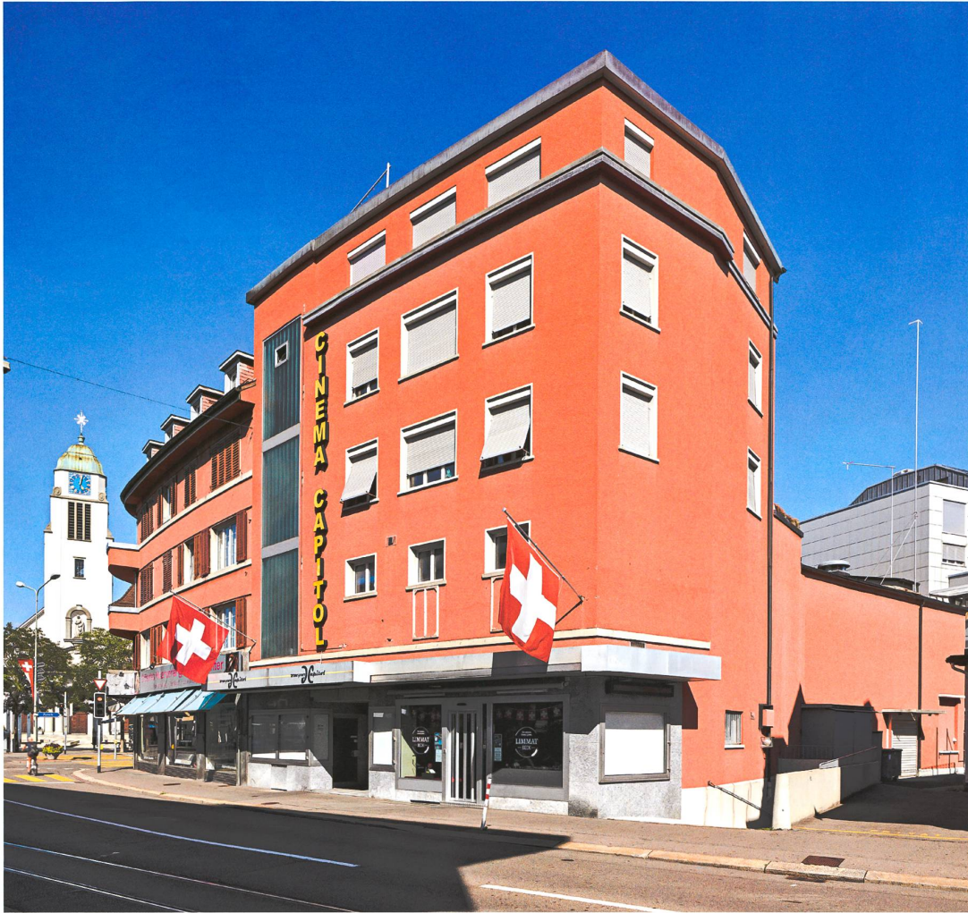
Abb.3 Dietikon, ehemaliges Kino «Capitol», erstellt 1930–1931 von E. Linggi-Schmidlin als Anbau des Wohn- und Geschäftshauses, das über der Brandstätte des alten Gasthauses Löwen errichtet wurde. Baumeister war Hermann Mäder, dessen Vater Louis bei Brown Boveri in Baden ebenfalls als Baumeister tätig war. Foto Dirk Weiss 2019
