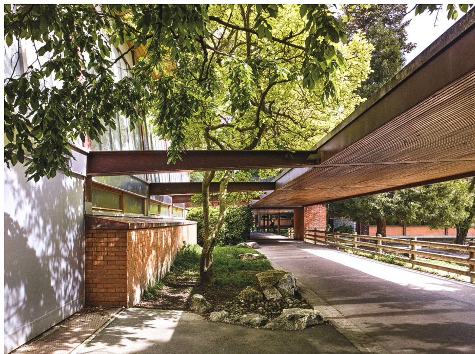
Chemin de liaison abrité entre les bâtiments C et D. Le plafond de cette structure extérieure est revêtu de lames de sapin, à l'instar des couloirs intérieurs qui semblent ainsi se prolonger dans la nature. Photo Dirk Weiss
