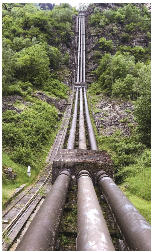
« In alto e al centro. La Grande Dixence nella Valle di Hérémece VS è, con i suoi 285 m, la diga più alta della Svizzera. La prima diga fu costruita già nel 1934. Foto Michael Peuckert
