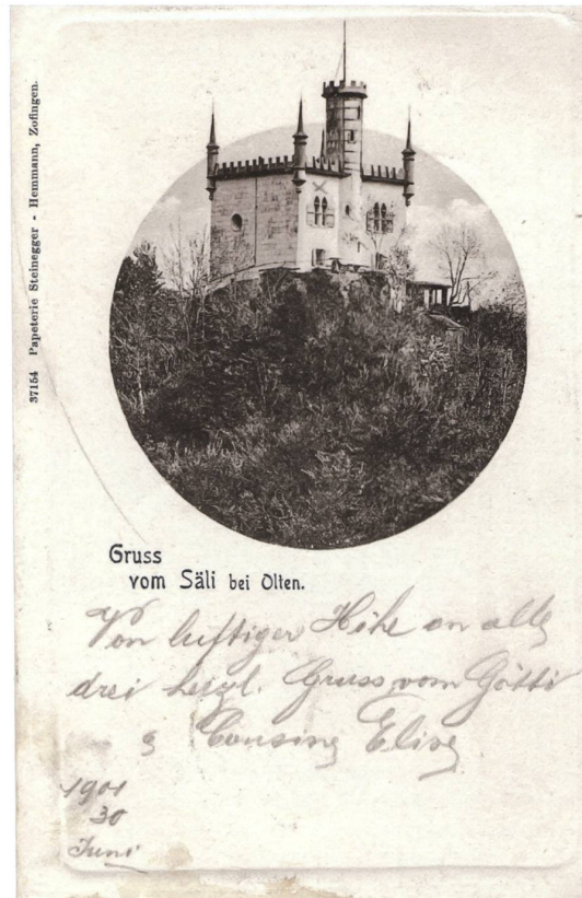
Olten, Sälischlössli, Postkarte von 1901. Die Ecktürmchen des 1870/71 über einer Burgruine errichteten Ausflugslokals waren aus Dampfkesseln von ausrangierten Lokomotiven gefertigt
