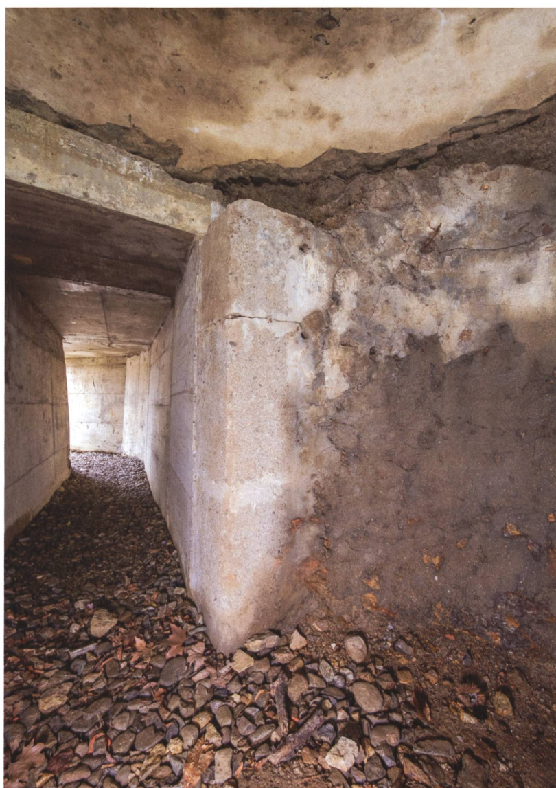
Fig.6 Lo sbocco del cunicolo all'interno della cella di refrigerazione dopo il consolidamento. © Sabrina Montiglia
