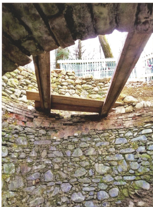
Fig.4 Veduta dall'alto durante lo sgombero dell'interno: si riconoscono il restringimento del vano inferiore, intonato con malta di cemento, una delle travi di metallo su cui poggiava il pavimento e l'intonaco a calce della camera superiore. © Flavio Zappa
