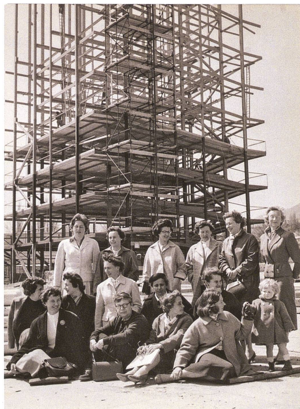
Gruppenaufnahme der Architektinnen der SAFFA 1958 vor der Baustelle des Wohnturms. Für viele Schweizer Architektinnen der zweiten Generation erwies sich diese Ausstellung als Plattform zur Präsentation des eigenen Werkes vor einer breiten Öffentlichkeit. Im Vordergrund (Zweite von rechts) ist die Chefarchitektin Annemarie Hubacher-Constam zu erkennen. Aufnahme von Philippe Giegel, ONST, Office national suisse du tourisme. Foto gta Archiv/ETH Zürich, Nachlass Hans Hubacher und Annemarie Hubacher-Constam
