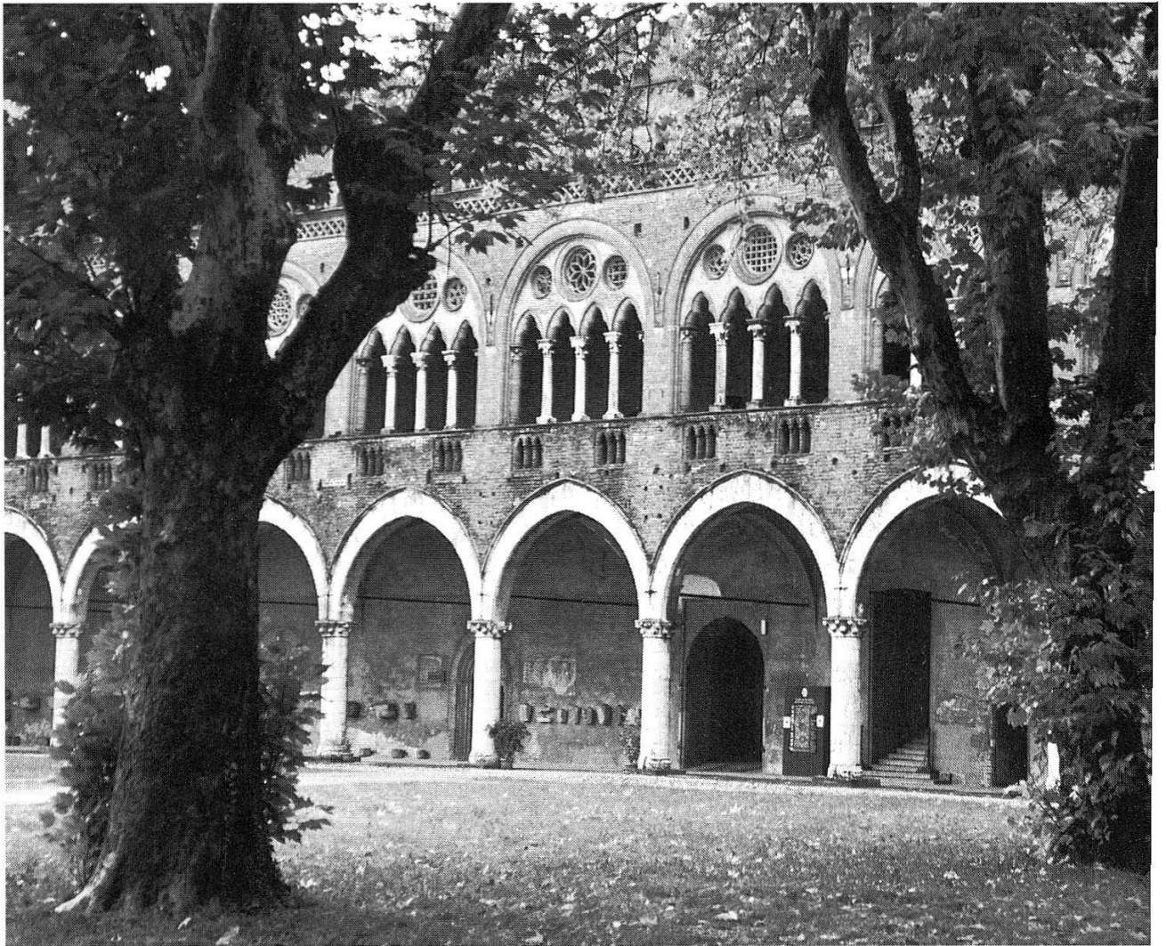
Palazzo Visconteo, Pavia
