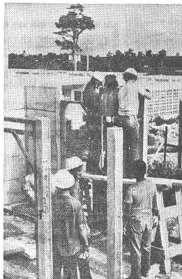
Bauarbeit in «Los Naranjos»
