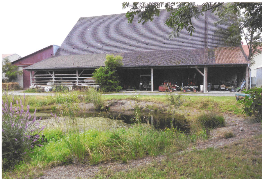
Von zwei Dächern läuft das Wasser direkt in den neu angelegten Teich mit Versickerungsgrube und Reinigungszone, von zwei anderen Dächern läuft das Wasser erst in die Zisterne und nur der Überlauf speist den Teich, aus dem übrigens auch Karpfen, Barsche und Zander gefangen werden können.
