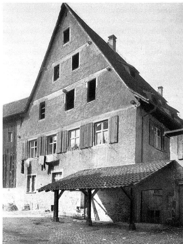
Abb. 4. Die Rychmühle. Fot. Öff. Denkmalpflege Basel-Stadt.
