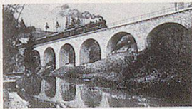
Galgentobelbrücke (St. Georgen) in Gellen, erbaut im 18. Jahrhundert (St. Georgen) in Gellen.
