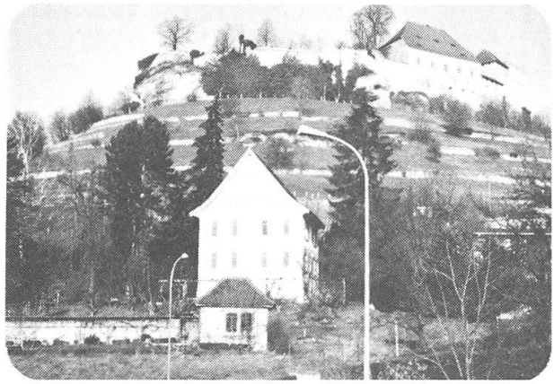
Abb. 46, Beispiel eines die Sichtbeziehung störenden Elementes
