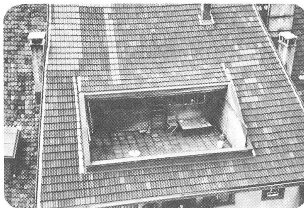
Abb. 101, Gegen die Regel verstossender neuerer Dacheinschnitt (Brättligäu)
