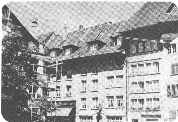
Abb. 100, Neuere Dachaufbauten (Leuengasse)
