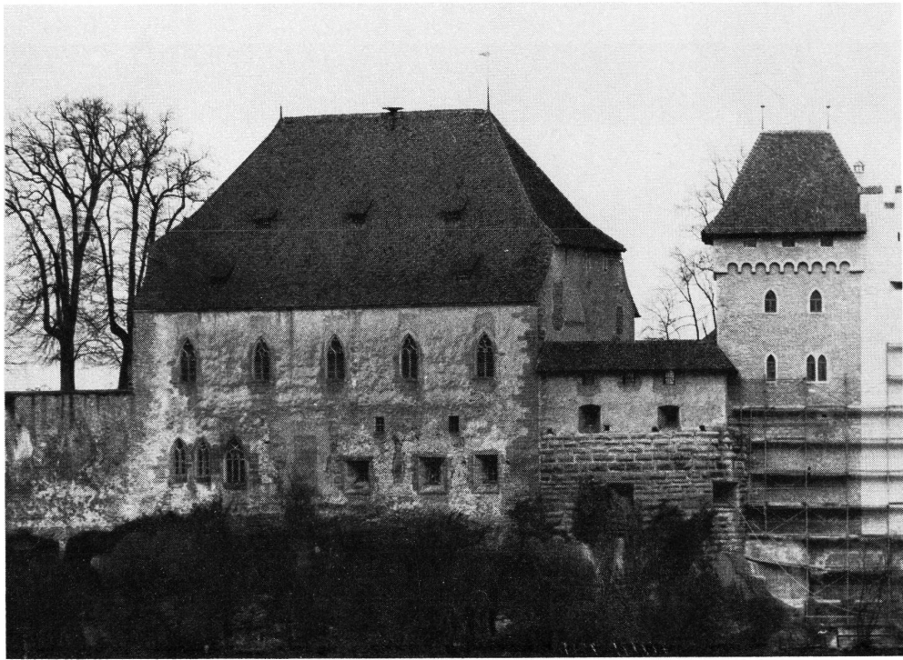
Das Ritterhaus vor der Restaurierung, Südansicht
