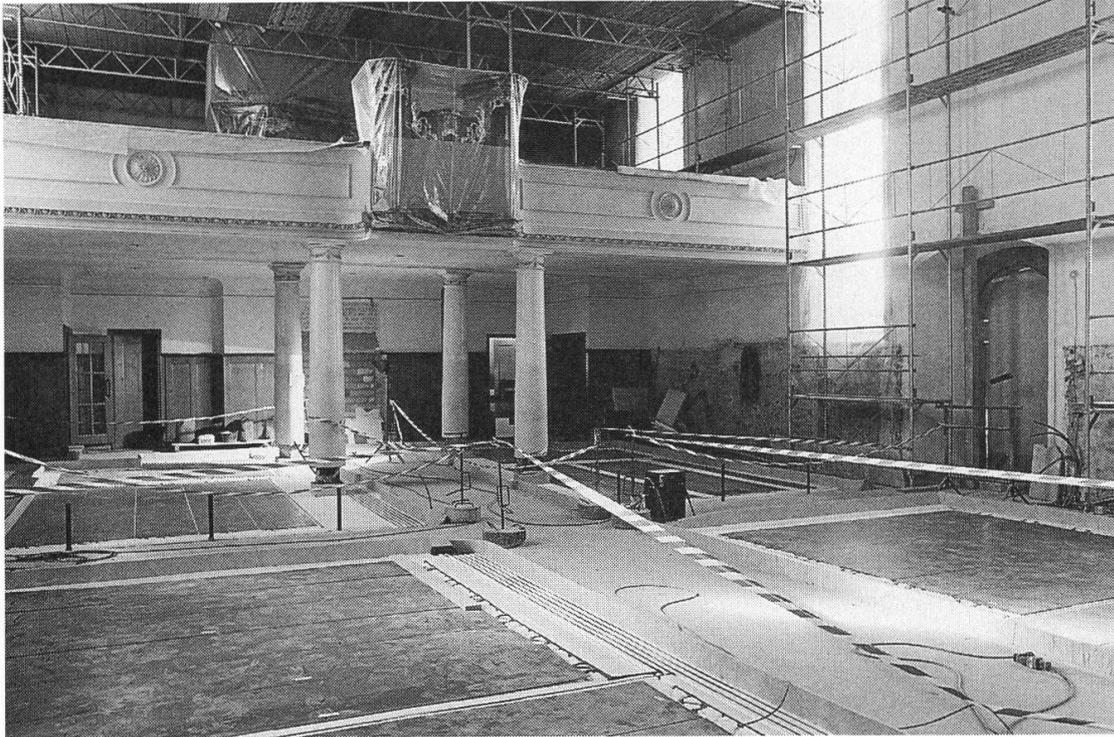
Blick ins Kirchenschiff während der Bauzeit. Zu beachten ist die fertig montierte Platten-Bodenheizung. (Fotos: Hans Weber).
