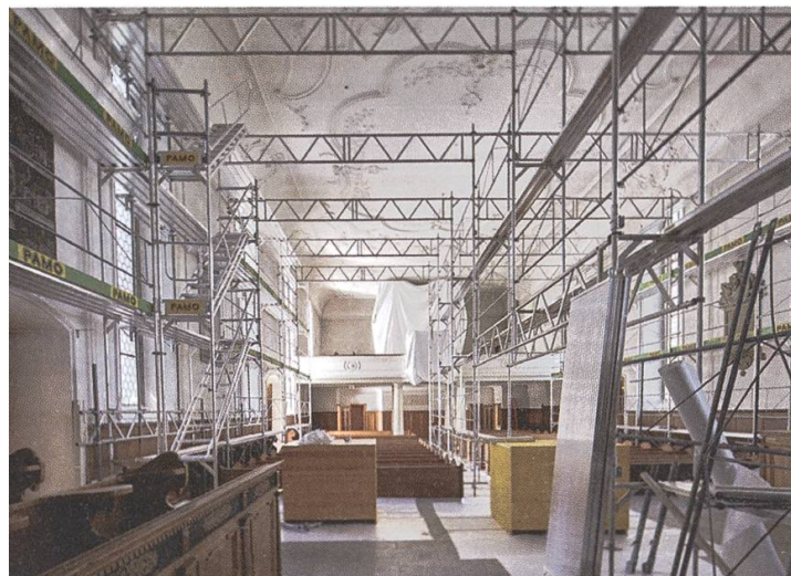
Die diffizile Restaurierung der Stukkaturen erforderte aufwändige Baugerüste. D. Schranz
