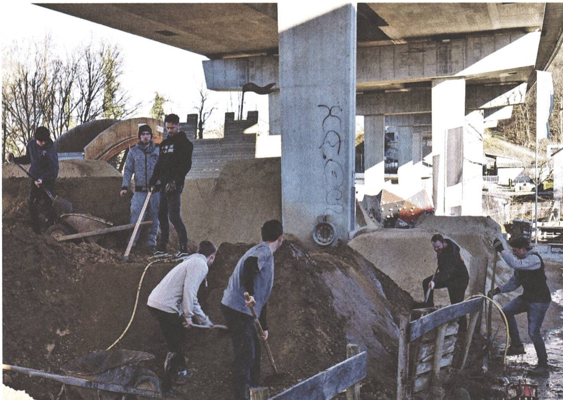
Umbau des Dirt-Jump-Parcours im Lenzburger Hammerpark T1
