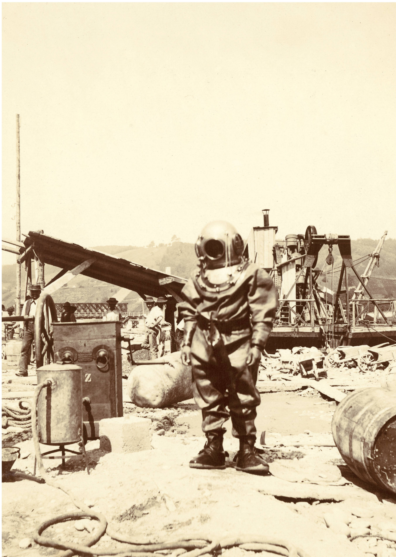
Plongeur sur le site de construction de la centrale hydraulique à Beznau an der Aare, 1901.
