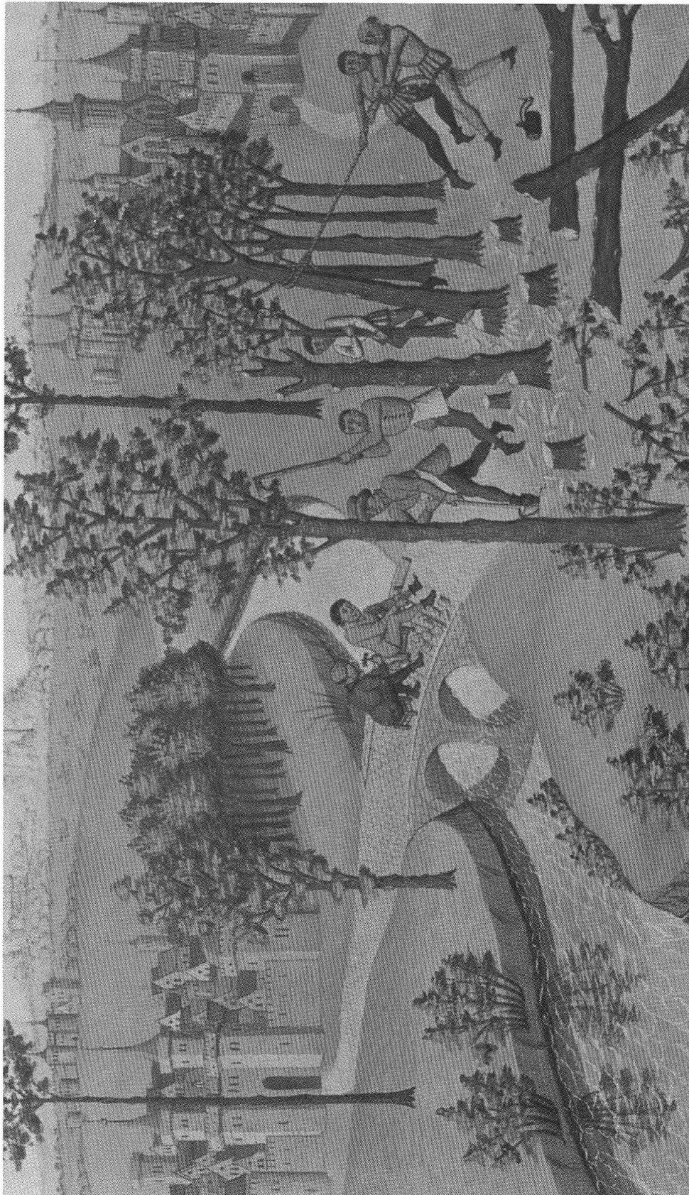
*Abb. 5: Dem Bau einer neuen, gepflästeren Strasse vor den Toren einer Stadt in Flandern muss eine Baumgruppe weichen. Vor dem Fällen der Bäume wurden diese möglichst weit hinauf entastet; der keilförmig eingehauene Stamm wird mit Hilfe eines Seiles umgerissen. — Bibliothèque Royale, Brüssel (Photo aus: Hans Hürzer, Die Strasse. Vom Trampelpfad zur Autobahn. Lebensadern von der Urzeit bis heute. München 1971, Abb. Nr. 179, S. 153).*
