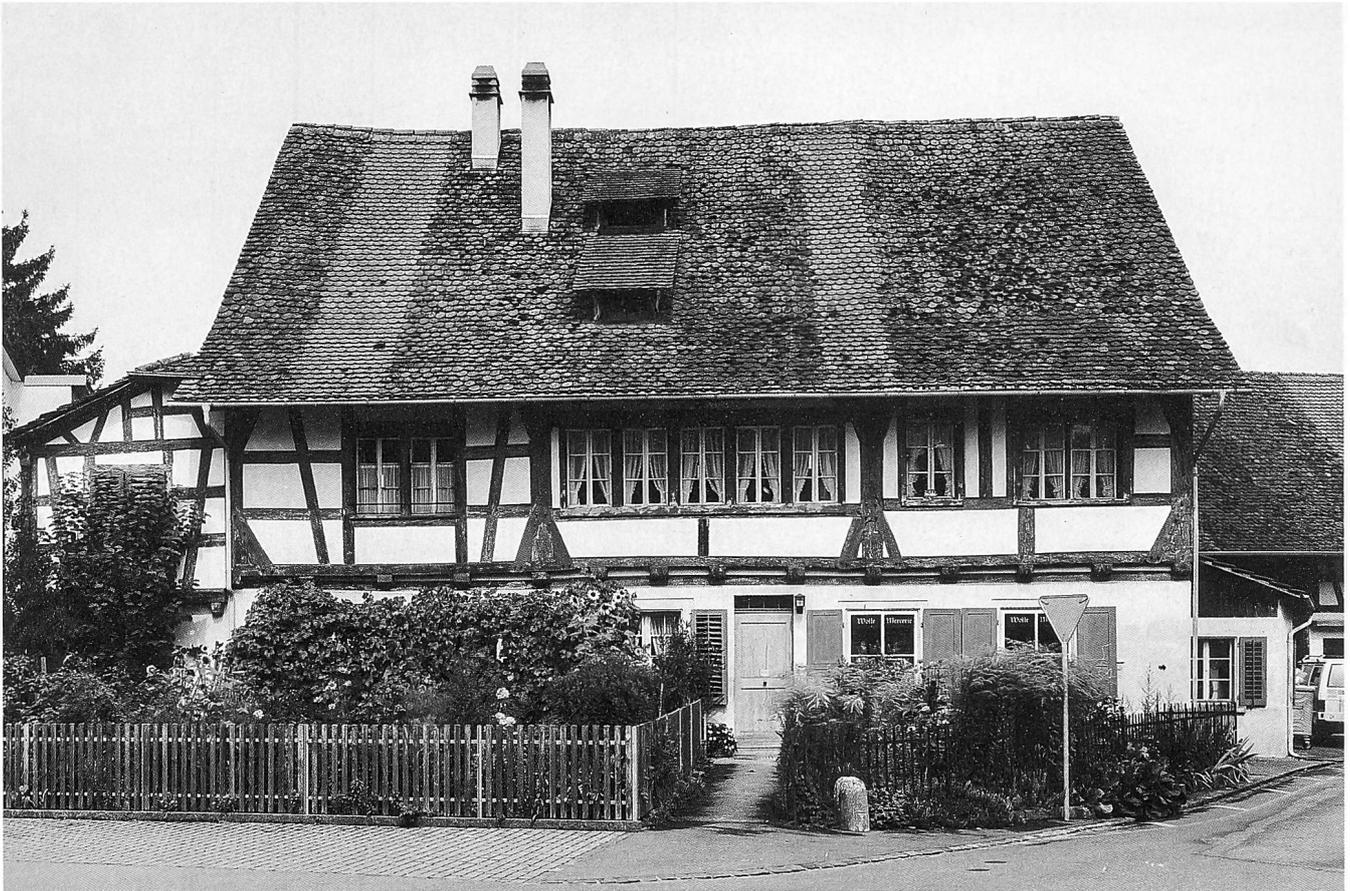
Strassenseitige Fassade. Aufnahme 1994. Die Ständer im ersten Obergeschoss mit den Fuss- und Kopfhölzern markieren die ursprüngliche Innenunterteilung in Küche (links), Stube (Mitte, mit fünfteiligem Reihenfenster) und Kammer (rechts). Links an das Gebäude wurde 1757 eine «Anhänke» angefügt, die im Obergeschoss das Studierzimmer des Pfarrers enthielt.
