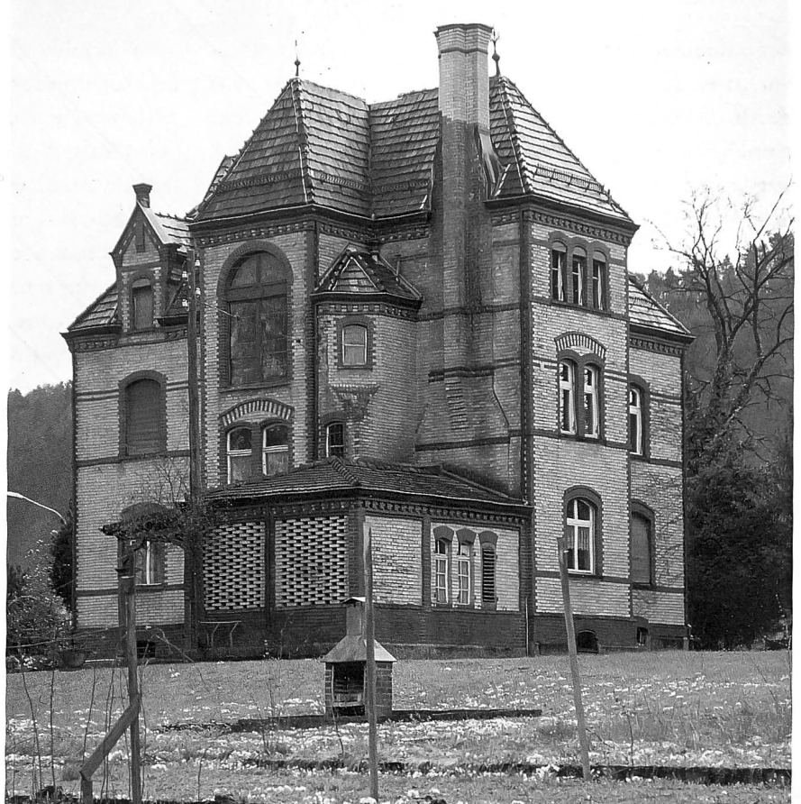
Der Ziegeleibesitzer Johann Jakob Keller liess 1895 vom bekannten Winterthurer Architekten Ernst Jung eine repräsentative Sichtbacksteinvilla errichten, deren abwechslungsreiche Fassadengestaltung neben dem Farbwechsel der Backsteine ein prägendes Element darstellt. (Fotos Kantonale Denkmalpflege Zürich).
