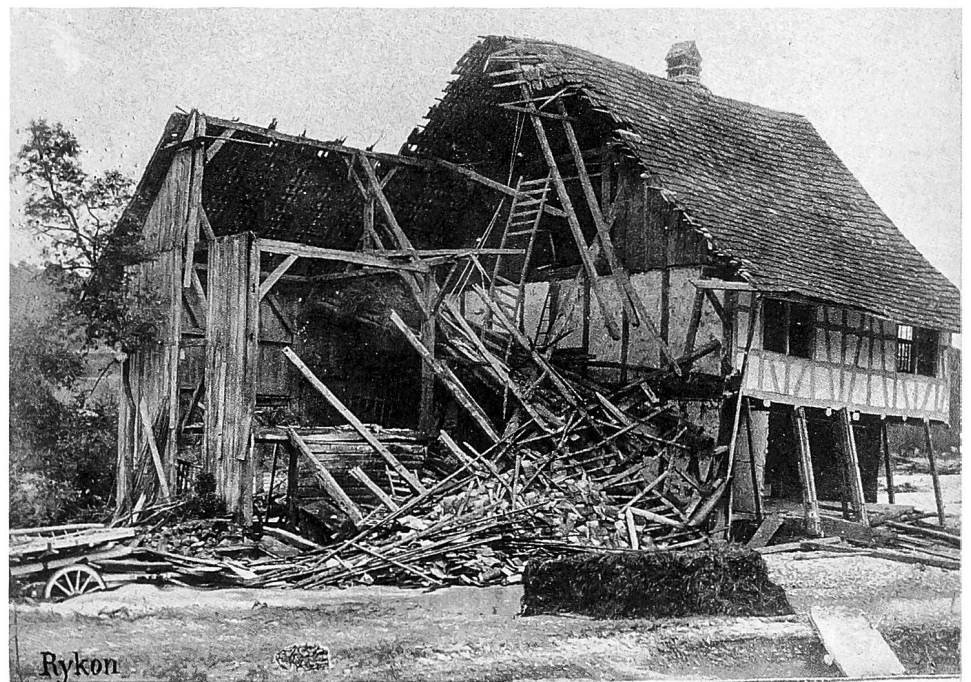
Die Tössbrücke in Wila 2004; eine Abbildung von J. Brunner zeigt die verheerenden Schäden des Töss-Hochwassers vom 11. und 12. Juni 1876 in Rikon. (Fotos Kantonale Denkmalpflege Zürich)
