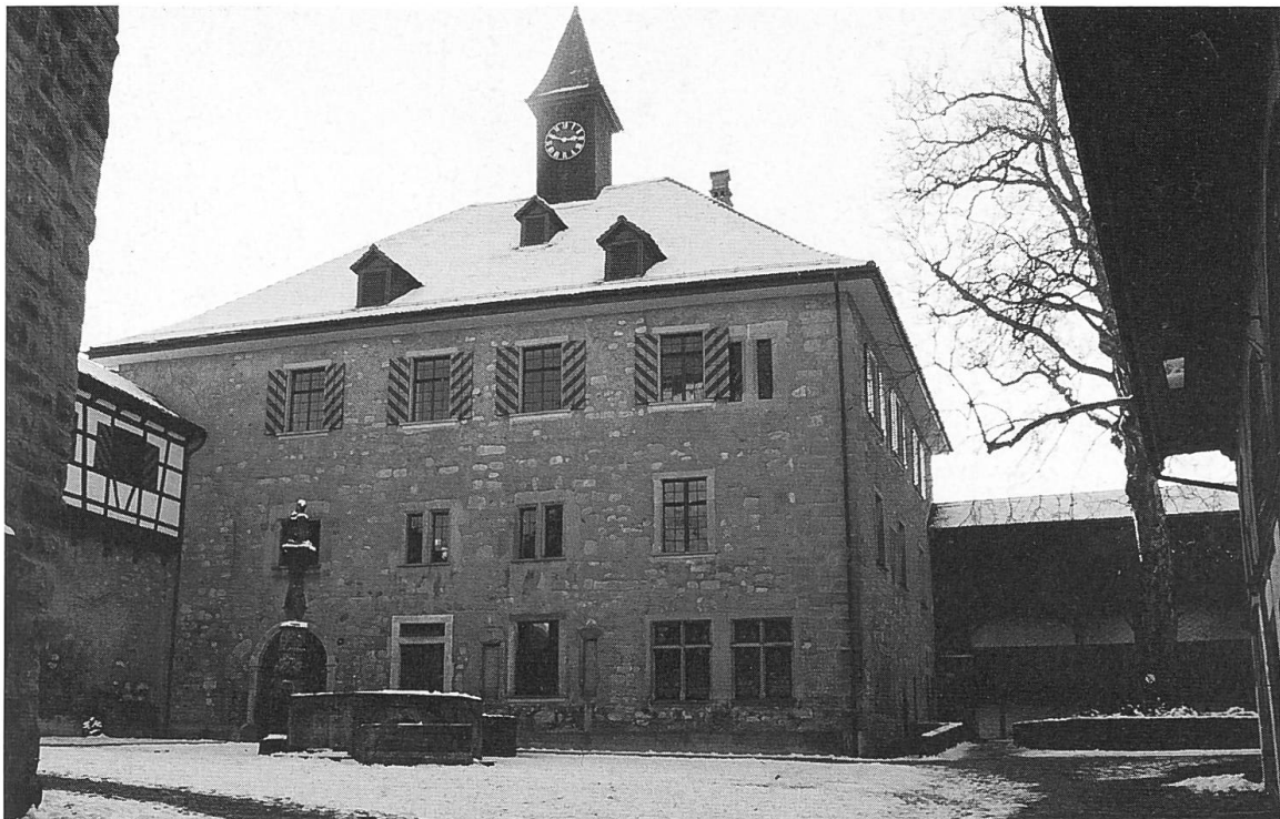
13. In der ersten Hälfte des 14. Jahrhunderts oder um 1370 entstanden die beiden hofseitigen Fassaden des Ritterhauses auf der Kyburg. (Foto Roman Szostek, Kantonsarchäologie Zürich)
