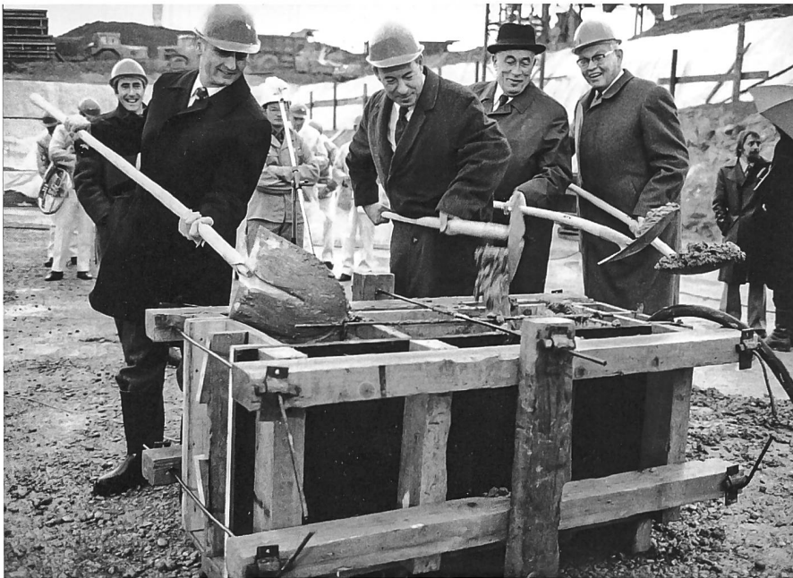
Abb. 2: Auf der grünen Wiese: Anfang Dezember 1973 erfolgte der Spatenstich für die erste Etappe des Campus Irchel der Universität Zürich: Regierungsrat Alfred Gilgen, Rektor Alfred Niggli, alt Erziehungsdirektor Walter König und Baudirektor Alois Günthard (von links nach rechts) tun gemeinsam den ersten Schritt.
