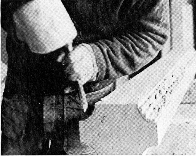
Die rohe Form eines Masswerkes — Fischblasenmotiv — wird bearbeitet.
