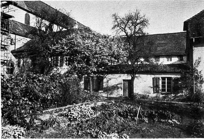
So präsentierte sich der Garten zwischen der alten Klostermauer und dem Westflügel vor Baubeginn 1974.
