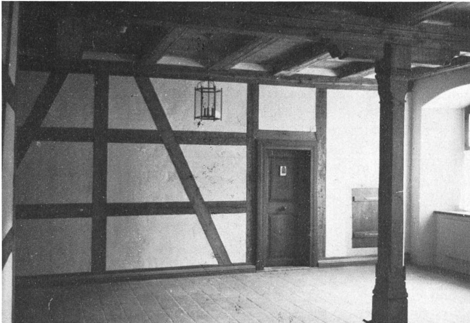
Konventstock, 1. Obergeschoss. Restaurierter Vorplatz bei der Wendeltreppe. Die Riegelkonstruktion ist wieder intakt. So sieht auch die Struktur des ganzen restaurierten Gebäudes aus.
