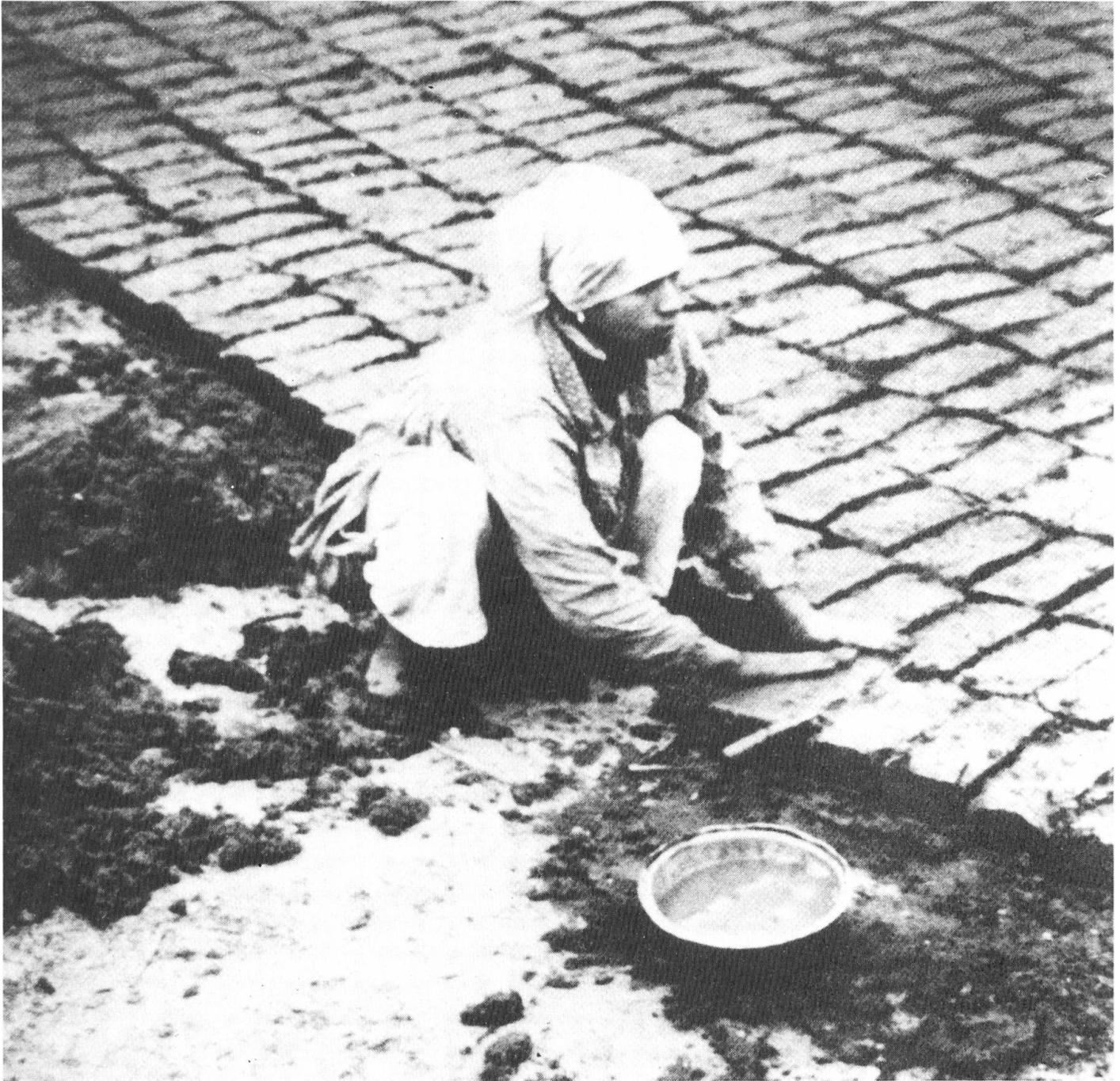
*Herstellung der sonnengetrockneten Ziegel, wobei kleingeschnittenes Stroh dem Nilschlamm als Bindemittel beigemischt wird.*
