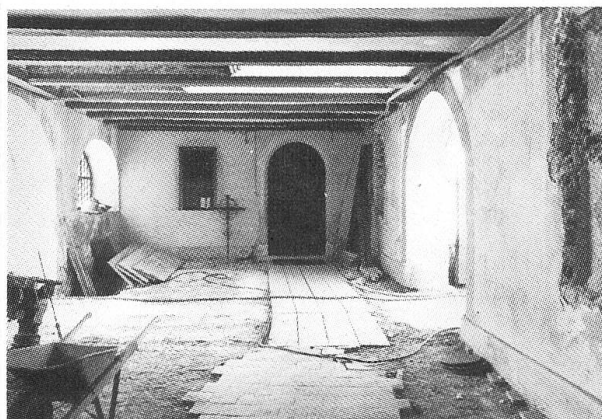
«Brüggli» im Umbau.
