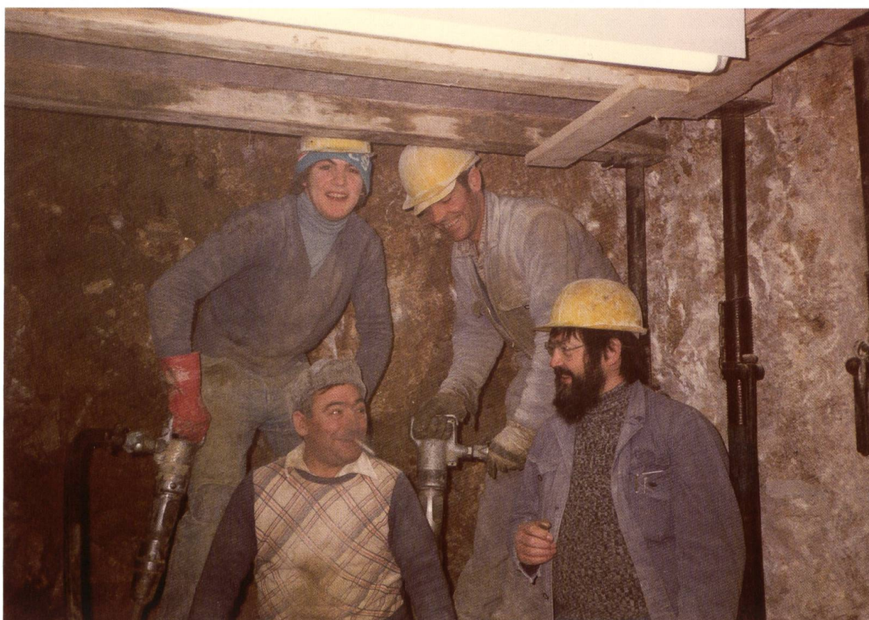
Vorstoss in die Tiefe: 1985 wird der Liftschacht in die Gnadenkapelle gebaut. Rechts: P. Bonifaz.
