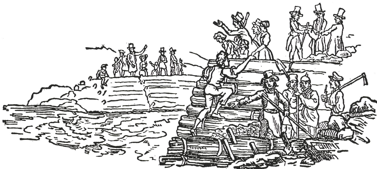
Hans Conrad Escher leitet 1811 die Linth in den Walensee. Der Durchbruch ermöglichte es in der Folge, die chronisch überschwemmte Gegend zu sanieren, die Flussstrecke trägt heute den Namen ihres Retters (Escherkanal). (Distelkalender, um 1835)
