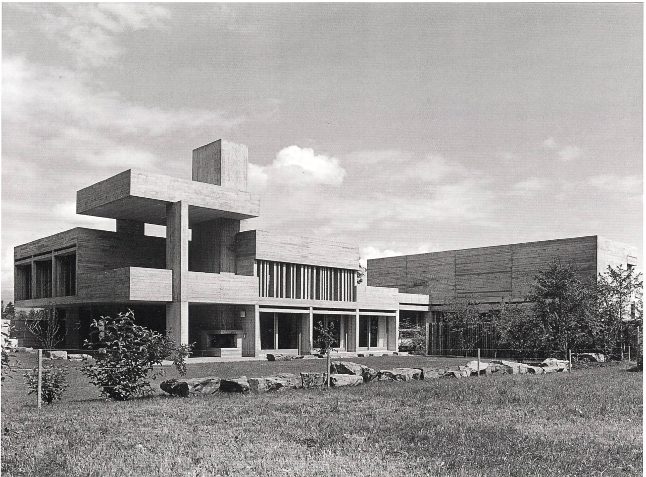
Eigenheim und im Hintergrund der Bürotrakt an der Zeughausstrasse 12, Lachen, 1965. Alle Fassaden und grosse Flächen im Innenausbau sind in schalungsrohem Sichtbeton ausgeführt.
