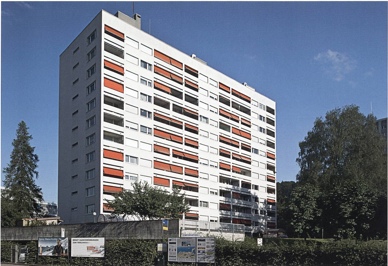
Ansicht des Hochhauses Churerstrasse 104-108 in Pfäffikon. Eine Gemeinschaftsarbeit der Architekten Adelbert Stähli, Umberto Butti und Josef Müller aus den Jahren 1959-1964.
