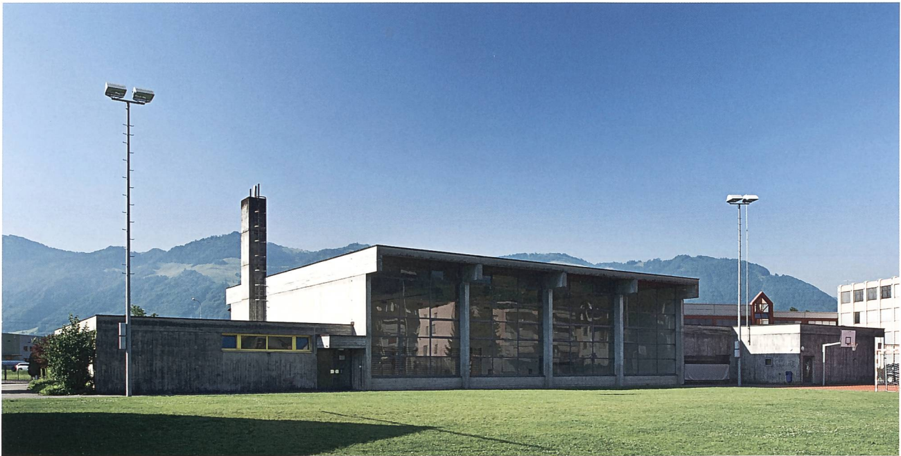
Fotografie des 1967–1969 erstellten Mehrzweckgebäudes mit Turnhalle, Schulzimmern, Gemeindeganzlei, Hauswartwohnung und Räumen für Militär und Feuerwehr in Tuggen.
