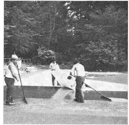
Lärchenplatz Magglingen: Verlegen der porenlösen Schaumstoff- platten
