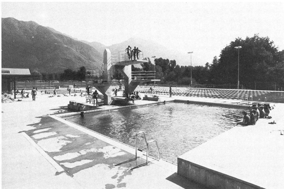
Das Freibad von Tenero mit Sprungturm, Springerbecken, 50-m-Schwimmbecken und Nichtschwimmerbecken. Links angeschnitten das dem Hallenkomplex integrierte Gebäude mit Verwaltung und Theorieräumen.
