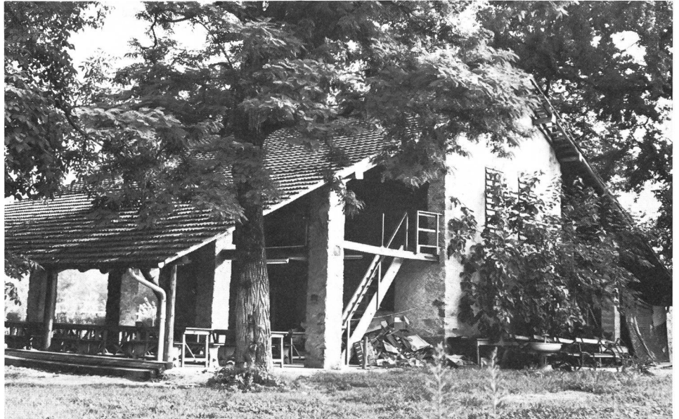
Der alte Tessiner Speicher im Jahre 1965, auch heute noch, im erneuerten Zustand, Mittelpunkt und Küche der Zeltplatzkurse.
