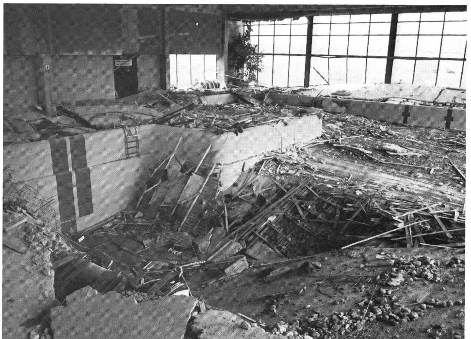
Bauschäden, die zur Katastrophe führten: Einsturz der Decke des Hallenbades von Uster am 9. Mai 1985, wobei zwölf Menschen ums Leben kamen. (Foto Keystone)
