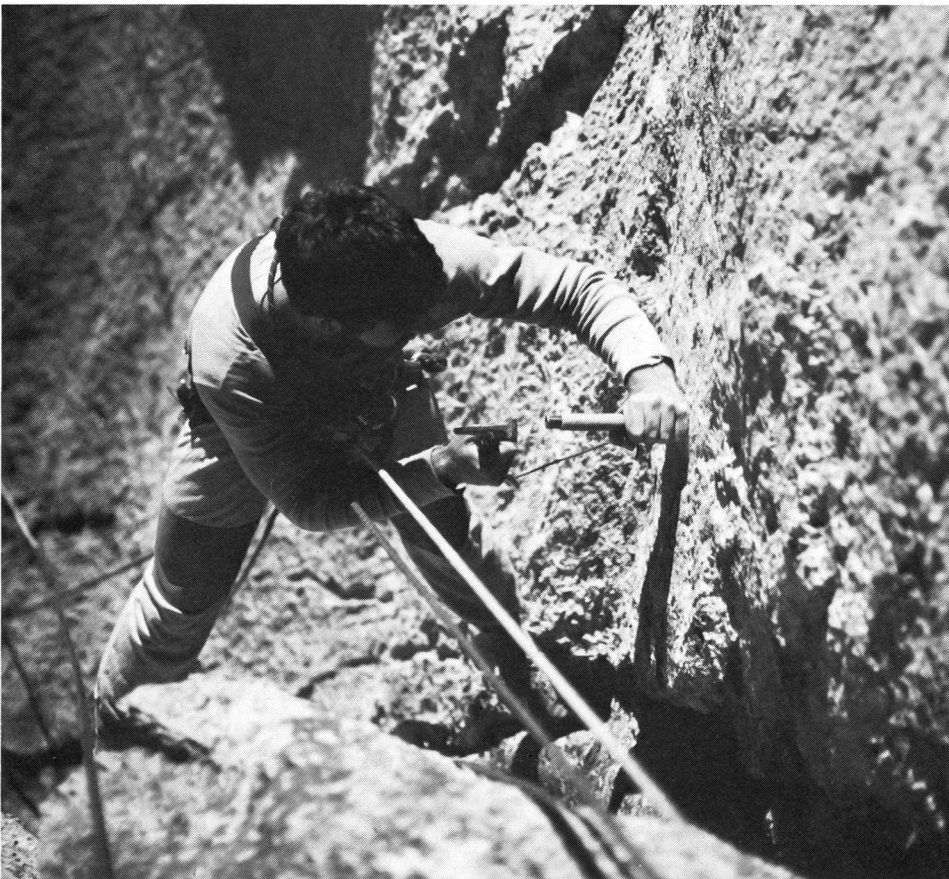
Absichern «von oben»: Aus dem hängenden Seil kann der Bohrhaken an jeder beliebigen Stelle gesetzt werden.
