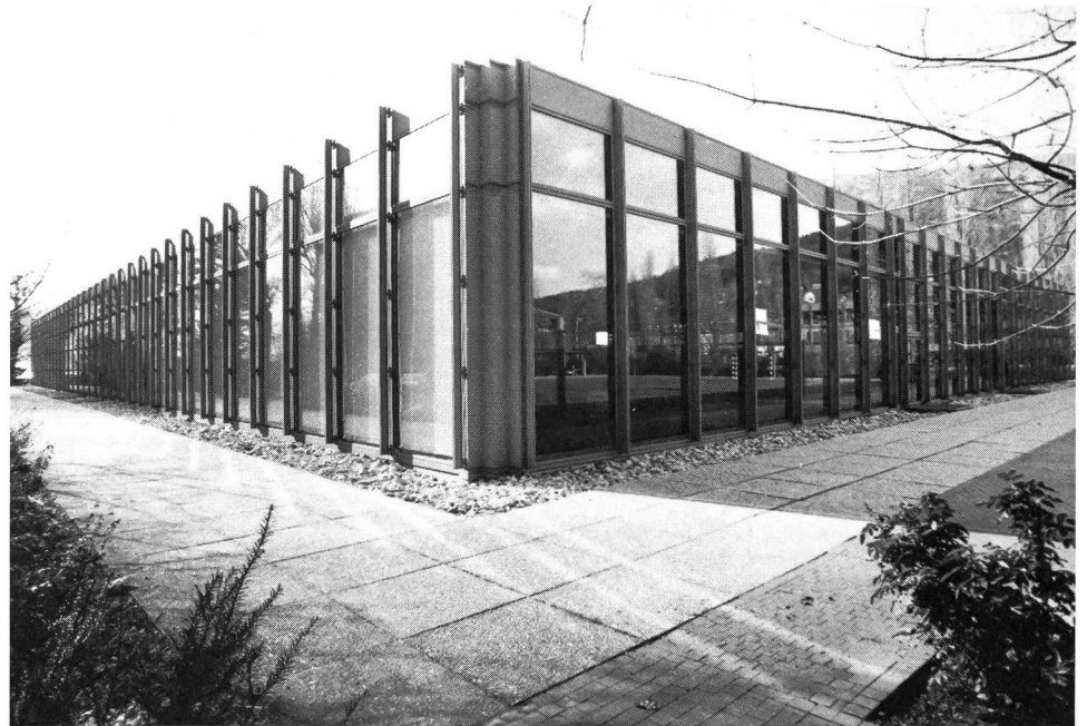
Aussenansicht der fünfteiligen Sporthalle des Gymnasiums Biel.
