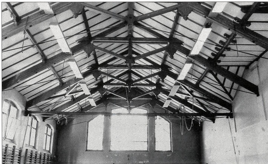
Turnhalle Spitalacker, Bern: Sehenswerte Dachkonstruktion. Fläche zur Verbesserung der Akustik mit schallabsorbierenden Platten.
