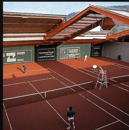
AGOB-Schiebedachhallen Tenniscenter Grütze Winterthur
