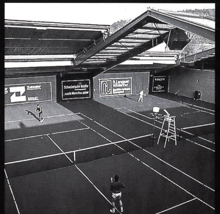
AGOB-Schiebedachhallen Tenniscenter Grüze Winterthur
