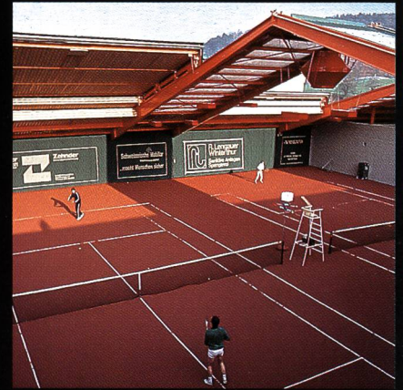
AGOB-Schiebedachhallen Tenniscenter Grütze Winterthur
